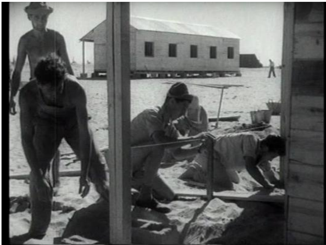
איור 2. הקמת דנגור. צילום מסך מתוך הסרט "בית אבי" שיצא בשנות הארבעים של המאה ה-20. הסרט הוא עלילתי, אך שולבו בו קטעים מתוך הקמת הקיבוץ. באדיבות "בית המגן"
